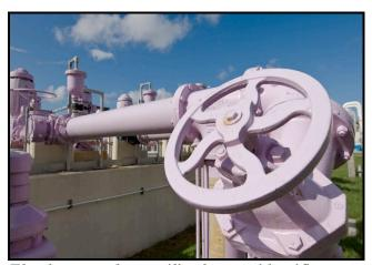
El color morado es utilizado para identificar a las bombas, tanques y tuberías que llevan agua recuperada. (Oprima la imagen para una versión más grande.)
