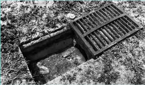
(Arriba) La entrada de la tubería para las aguas pluviales que se encuentra en un canal de conducción cubierto de césped está oculta por vegetación abandonada, suciedad y hojas. (Centro) El mantenimiento adecuado debe incluir inspecciones periódicas y la eliminación de materias inútiles y sedimento que pueden bloquear la corriente del agua. (Abajo) Una apertura libre asegura que el exceso de aguas pluviales pueda fluir por el sistema de drenaje, como fue diseñado.
