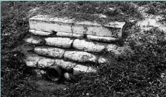
(Arriba) La entrada de la tubería para las aguas pluviales que se encuentra en un canal de conducción cubierto de césped está oculta por vegetación abandonada, suciedad y hojas. (Centro) El mantenimiento adecuado debe incluir inspecciones periódicas y la eliminación de materias inútiles y sedimento que pueden bloquear la corriente del agua. (Abajo) Una apertura libre asegura que el exceso de aguas pluviales pueda fluir por el sistema de drenaje, como fue diseñado.
