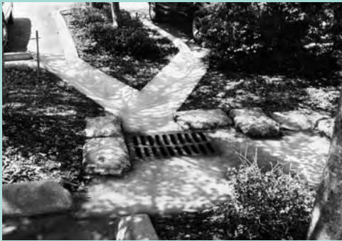
(Abajo) Ahora, la rejilla y el sistema de conducción pueden funcionar adecuadamente después de haber sido despejados de toda obstrucción.
